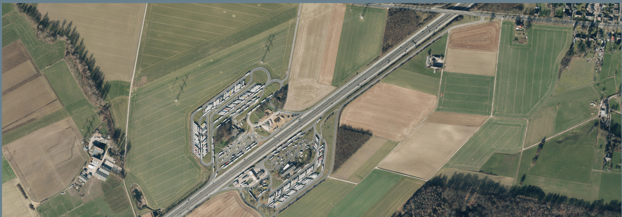
Luftaufnahme der Rastanlagen Aachner Land.
